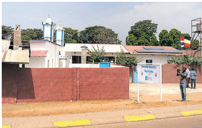
So sieht das „Health Center“ in Buniadu aktuell aus: Links befindet sich die gerade fertiggestellte Unterkunft für Personal und Freiwillige.
